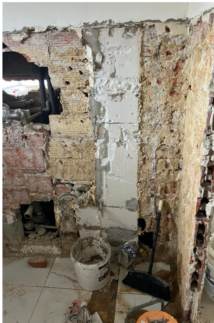
Byt na Kounici v průběhu rekonstrukce
