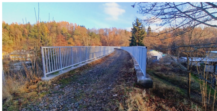
Železniční viadukt nad silnicí ve směru na Krásno
