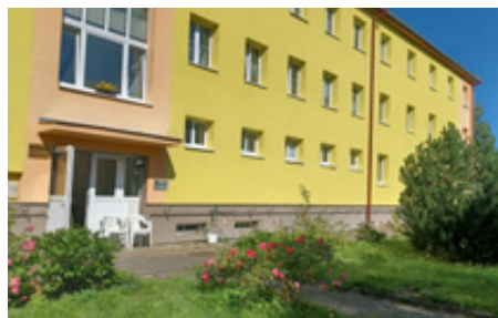
objekt s byty zvláštního určení Poštovní 656/10
