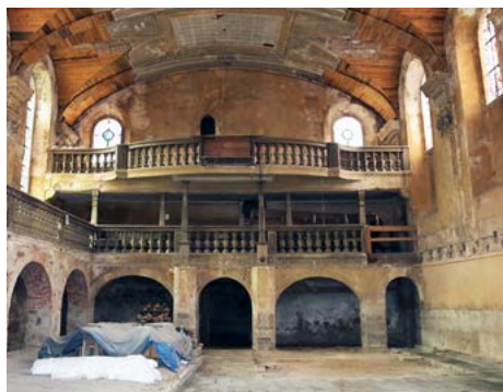
prostor kostela před rekonstrukcí
