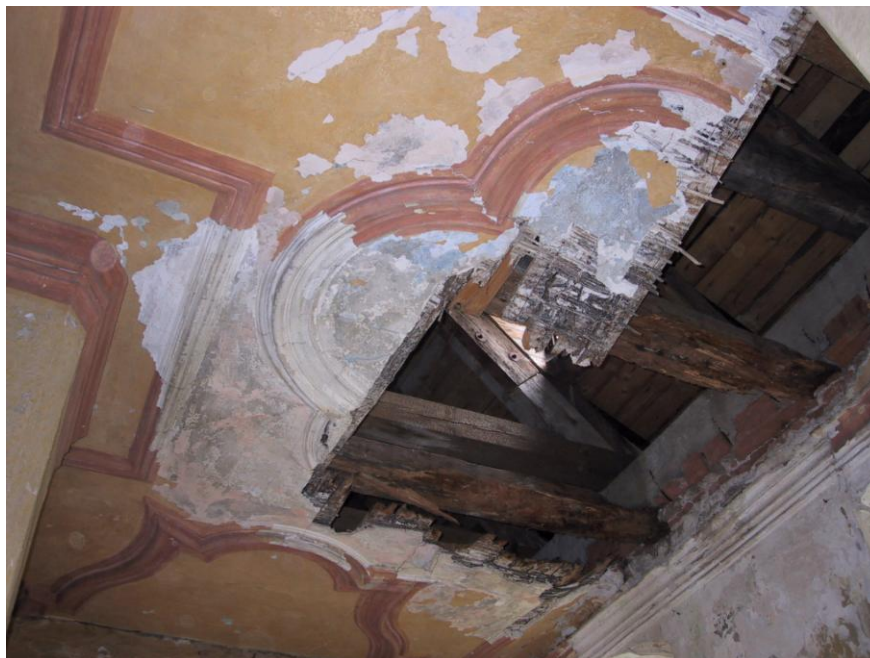
propadající se stropy
