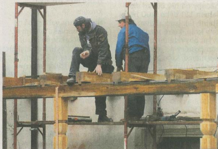
STAVBA NOVÉ dřevěné pavlače na Pluhově domě. Foto Deník/žip
