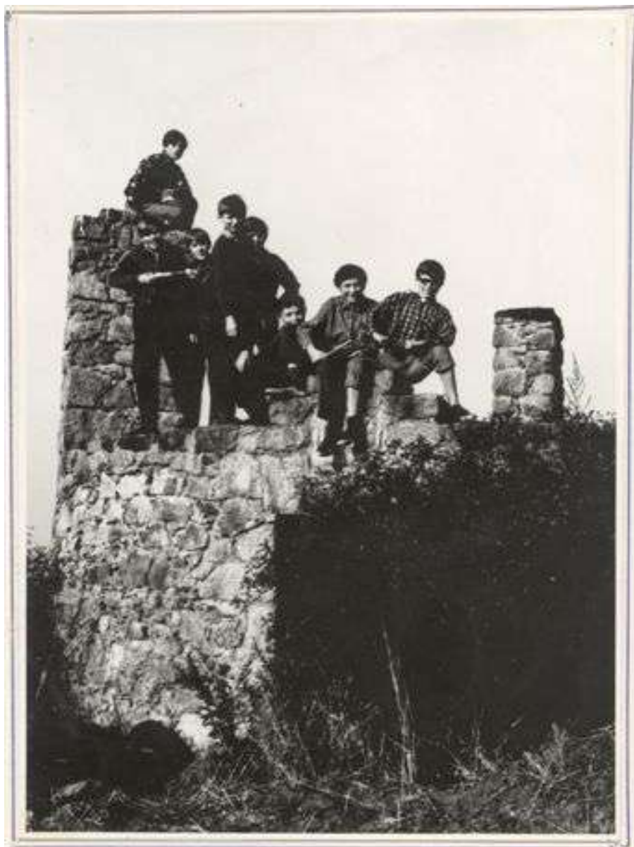
Úspěšný start Junáka v roce 1968 byl brno uviděn
